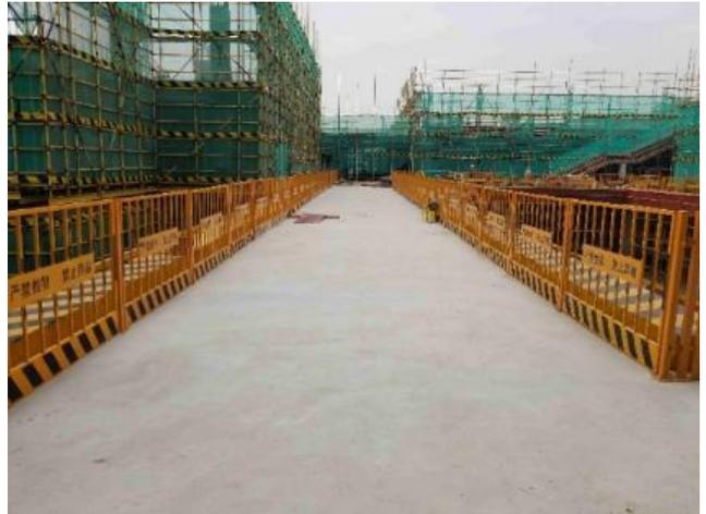
现场围挡采用 PVC 木塑围墙安装、拆卸方便快捷。并采用装配式工作梯可根据施工楼层进度加节搭设，施工简单，牢固可靠。
