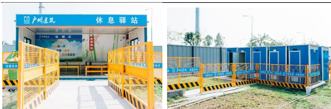
现场设置装配式茶水间、吸烟区及移动厕所，可多次周转使用。
