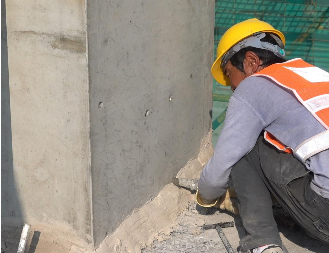
5、预制柱注浆施工
