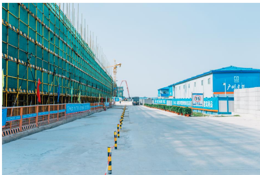
现场施工道路永临结合，节约用地。
