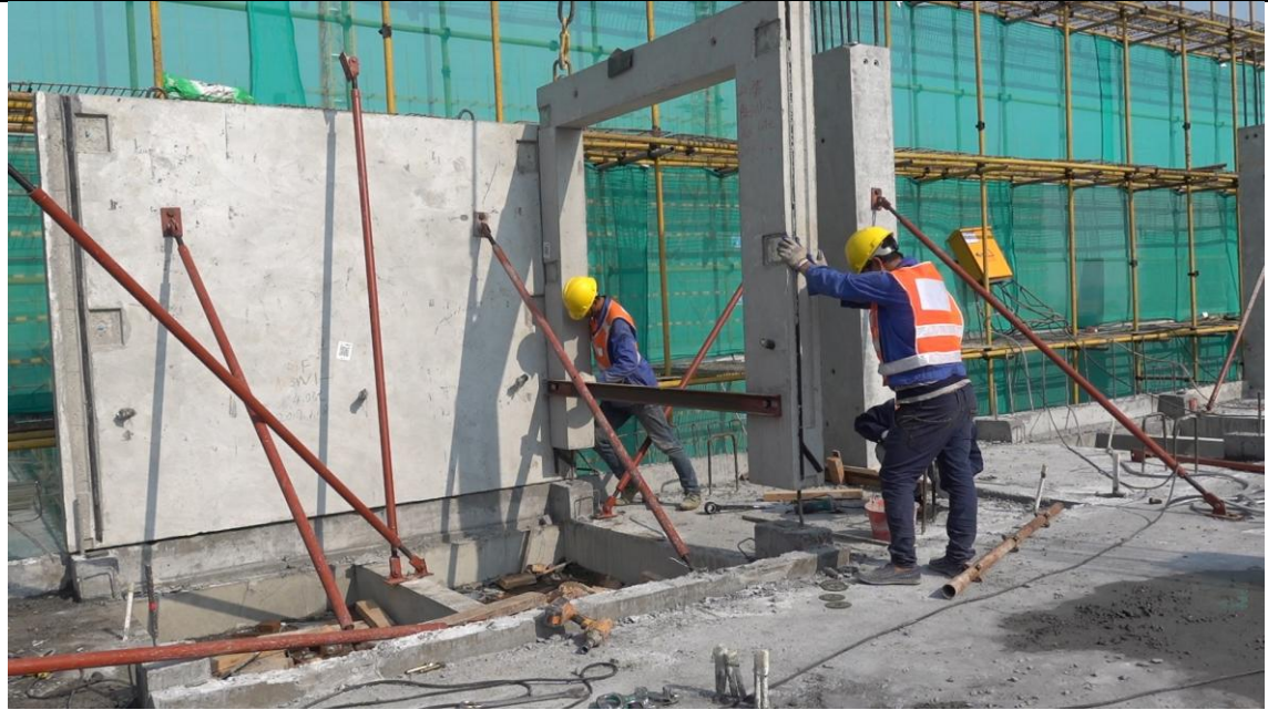
5、预制柱注浆施工
