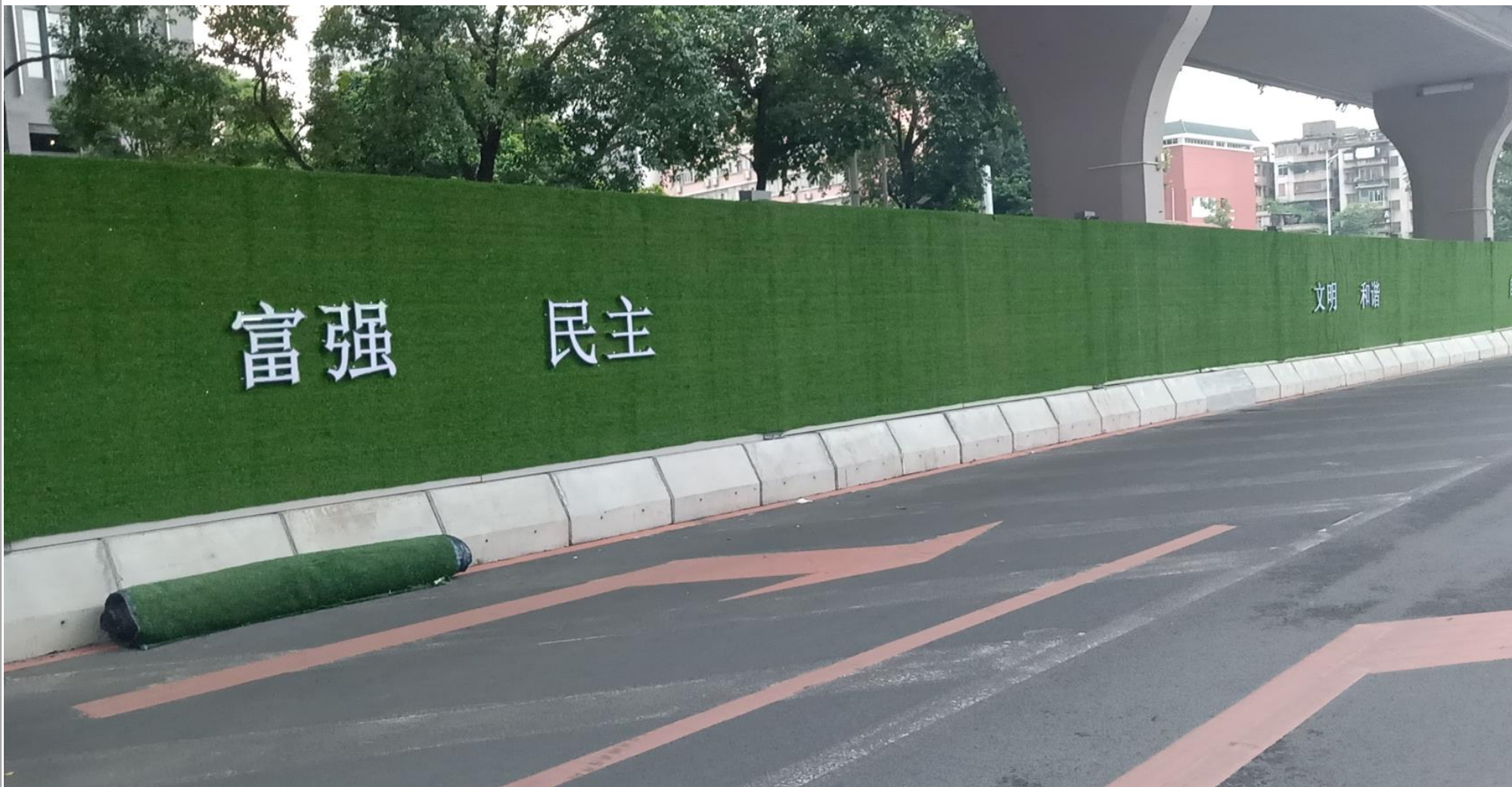
装配式轻钢结构围墙实际案例参考图
