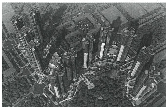
中山大学深圳校区人才保障性住房 深圳市人才安居工程高级人才房
