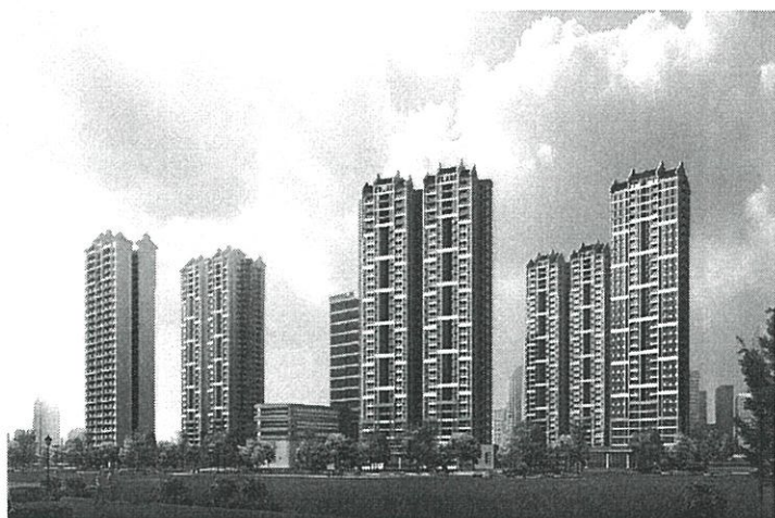
石丰路保障性住房建筑产业化项目 广州市政府第一个装配式保障房项目
