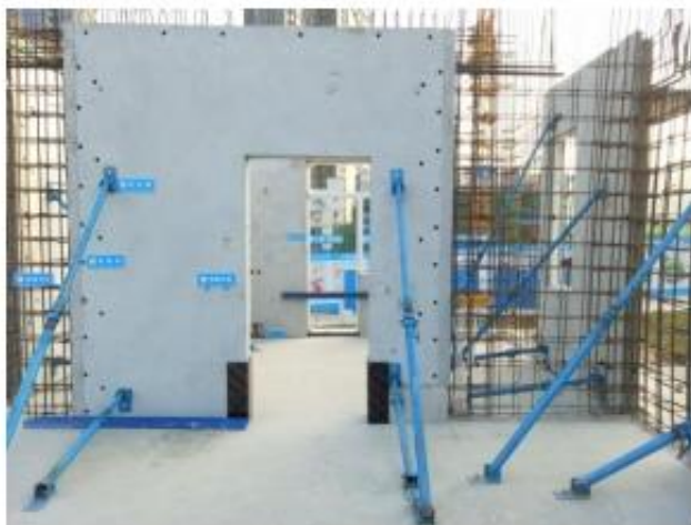
27. 装配式墙体安装
