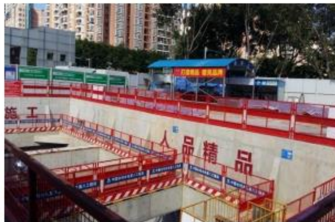
4. 基坑防护工具化、标准化
