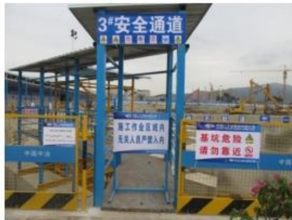
18. 基坑边防护规范，设置警示牌
