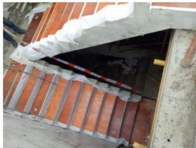
28. 装配式楼梯安装
