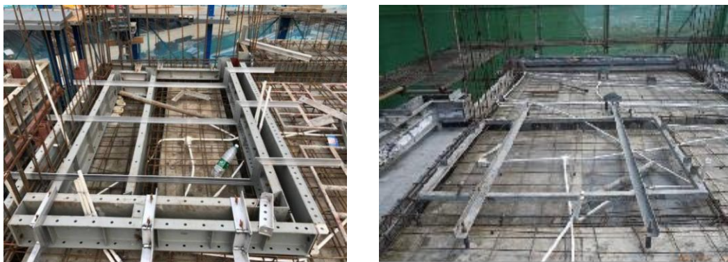
图 4.36 施工现场降板安装示意图
