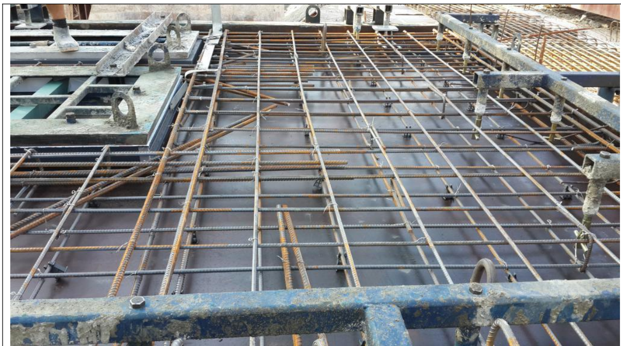
图 3.12 预制构件钢筋绑扎
