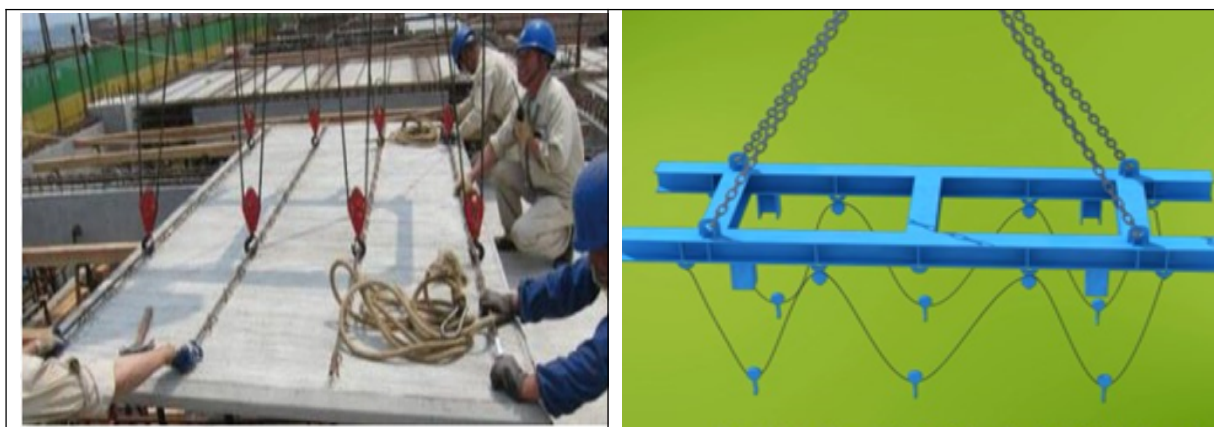
图 3.16 预制构件起吊
