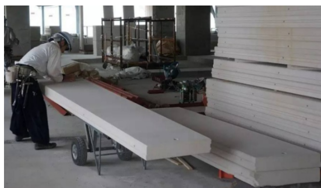
图 4.48 单块 ALC 墙板运输
