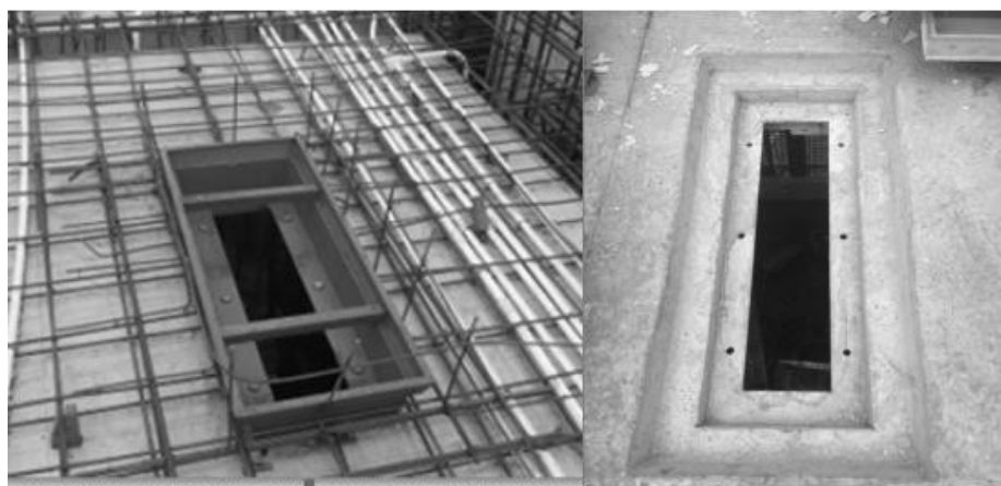
图 4.35 施工现场传料口示例图
