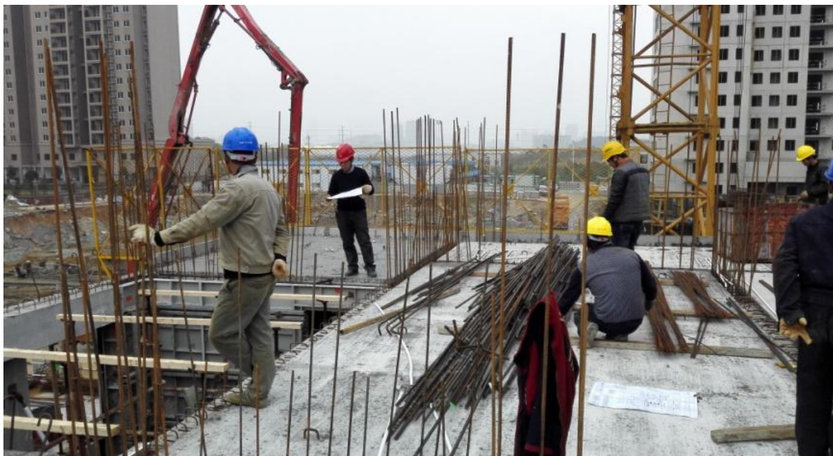
图 4.16 检查预埋孔洞
