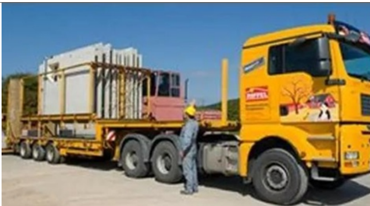
图 3.26 预制外墙板运输
