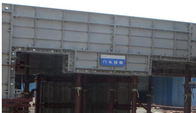
图 4.39 门头挂板配模示例图
