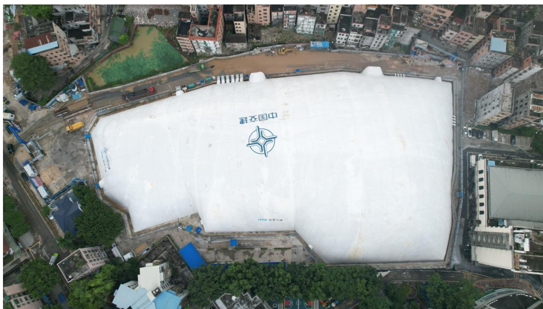
气承式基坑气膜安装完成实拍图
